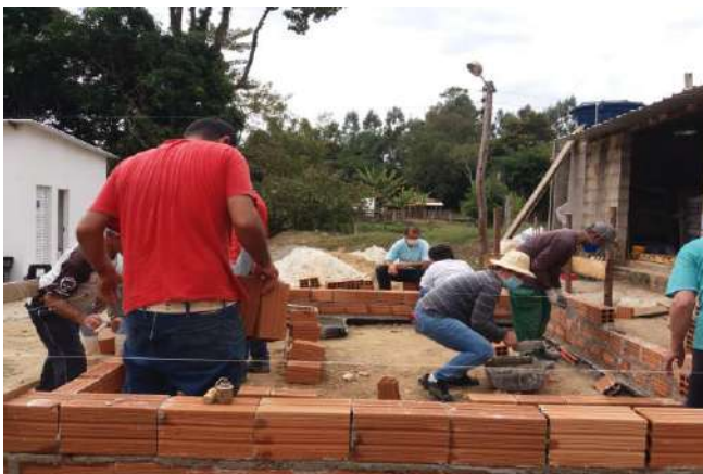
Foto 1 – Levantamento das paredes no Sítio Santa Maria Data: 16/07/2021
