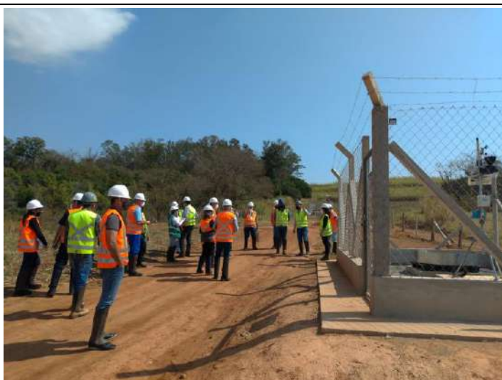
Foto 3 – Visita à obra BDP Comitê de Acompanhamento Data: 12/08/2021
