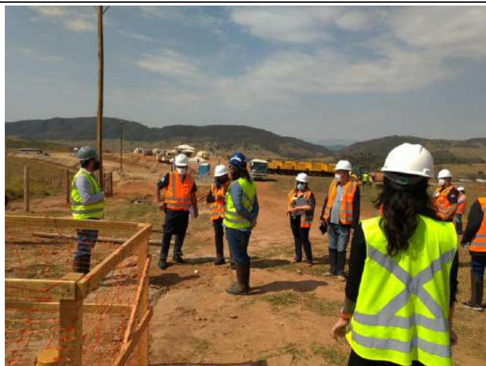
Foto 4 – Visita à obra BDP Comitê de Acompanhamento Data: 12/08/2021
